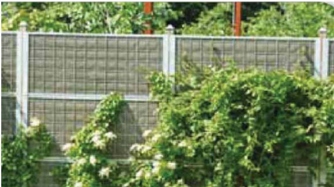
Akustisk hegn med stålramme, stenuld (akustisk kernemateriale) og grønt PE-net.
