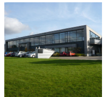
Lokalplanområdet set fra Bjarkesvej og det grønne areal
