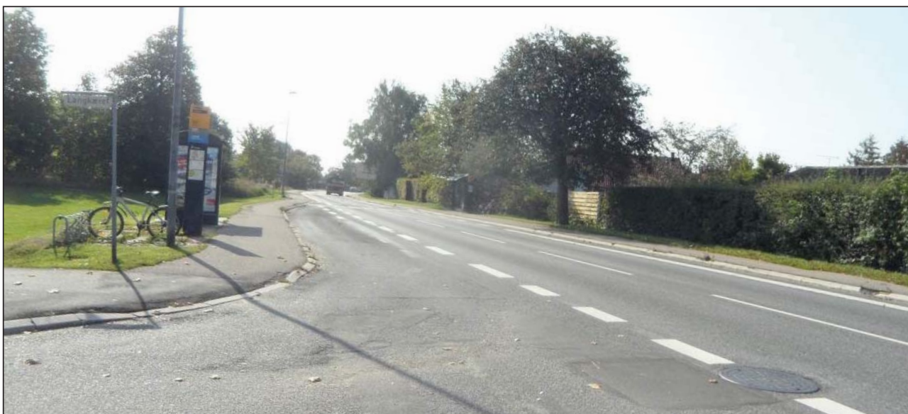
Langkæret ud mod Hillerødvej - set mod Slingerupvej
